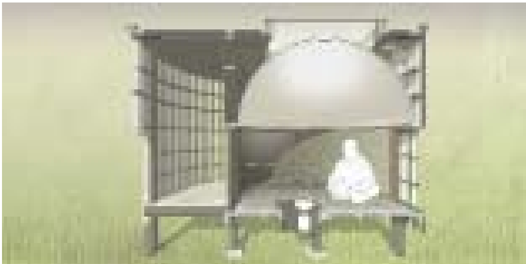
Veduta dell'interno con la cupola in carta pressata, il pavimento in resina e la finestra in lamiera riciclata.
